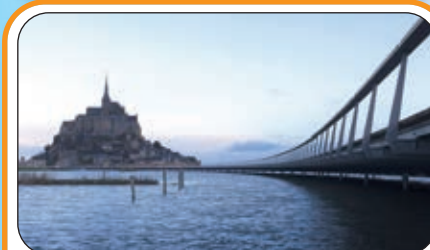
Nouveau pont-passerelle du Mont Saint-Michel
